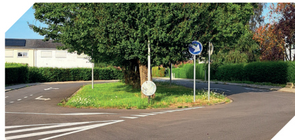
Villagexpo : rénovation des avenues principales et des trottoirs et mise en zone 30km/h.
